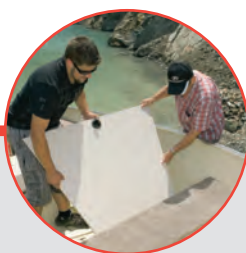
PLANCHER DE BOIS amovible traité sous pression recouvert de vinyle marin (pièces avant et arrière)
